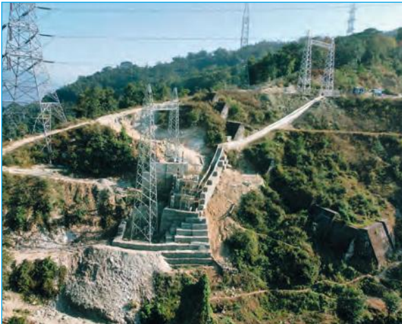
ढुङ्गेसाँघु सबस्टेसनमा निर्माण भईरहेको Tower To Tower Inter-Connection Arrangement का कार्यहरू
