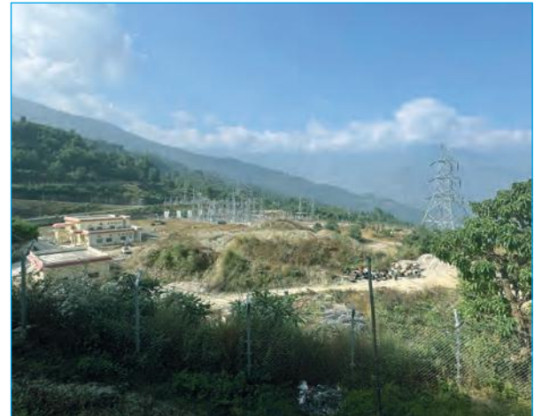
ने.वि.प्रा.को निर्माणाधीन ढुङ्गेसाँघु सबस्टेसन
