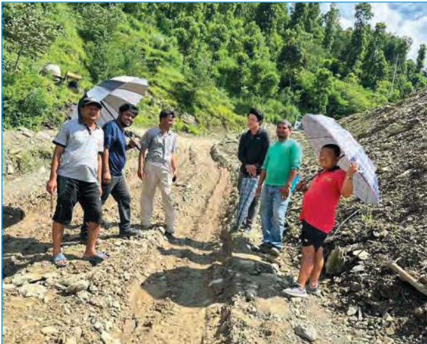
फुडलिङ नगरपालिका वडा नं. २ स्थित सडक मर्मतका लागि आयोजना र स्थानीयको संयुक्त अनुगमन
