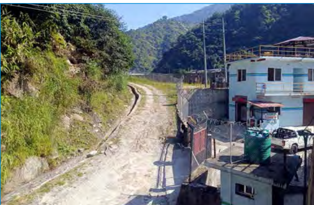
निकास प्रणाली, सडकको स्तरोन्नती तथा Flood Wall निर्माण कार्य
