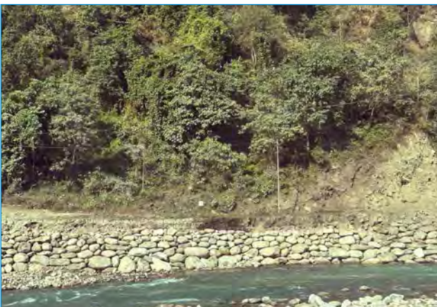
बेली ब्रिजको Downstream क्षेत्रमा बोल्डर Riprap कार्य
