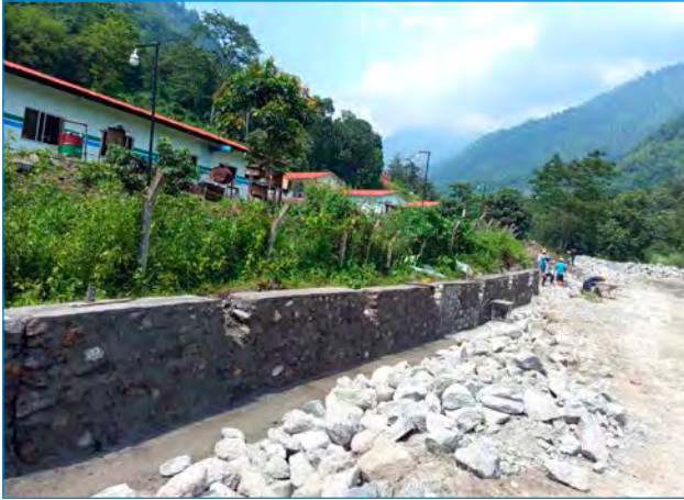
Stone Masonry Wall, Drainage तथा तारबार निर्माण कार्य
