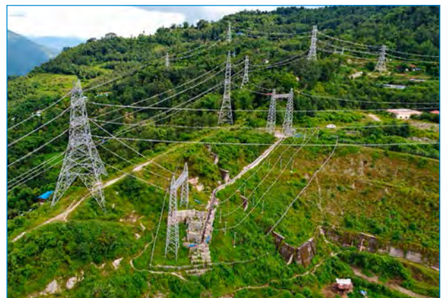
Over-Head Line निर्माण कार्य
