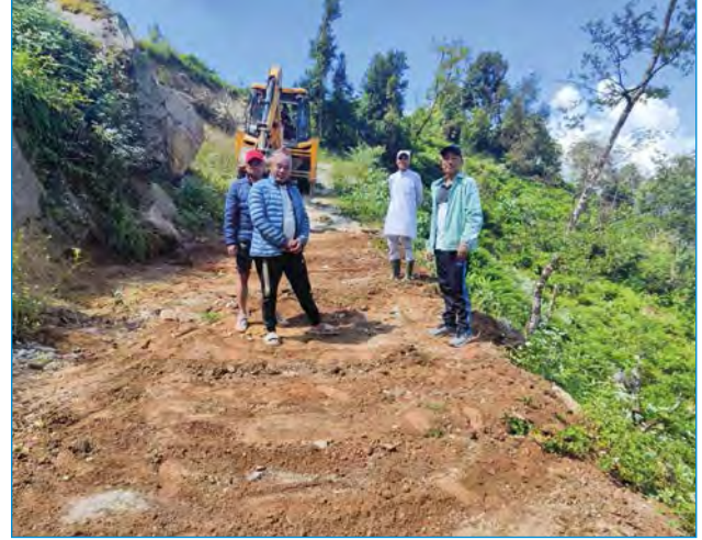
फुङलिङ न.पा.-१० को सहकार्यमा उक्त वडामा सडक मर्मत तथा स्तरोन्नतिमा सहयोग ।
