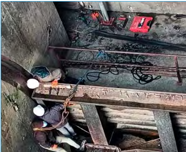
Weir-Side Top Seal प्रतिस्थापन कार्य
