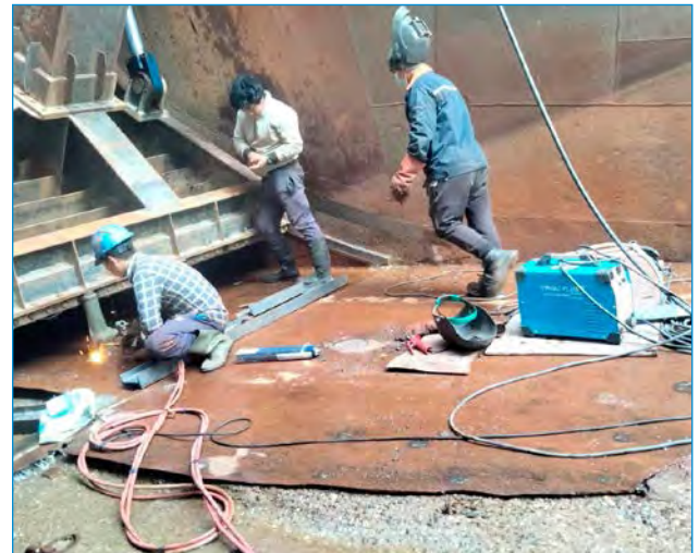
अन्डरस्लुइस Radial Gate को मर्मत कार्य
