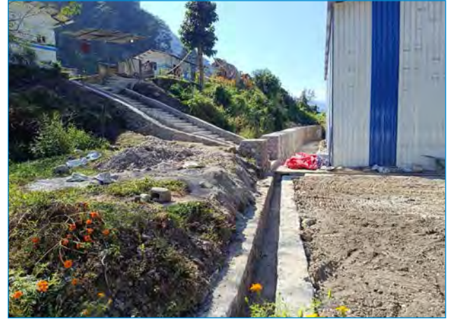
सिँढी, नाली तथा Masonry Wall निर्माण कार्य
