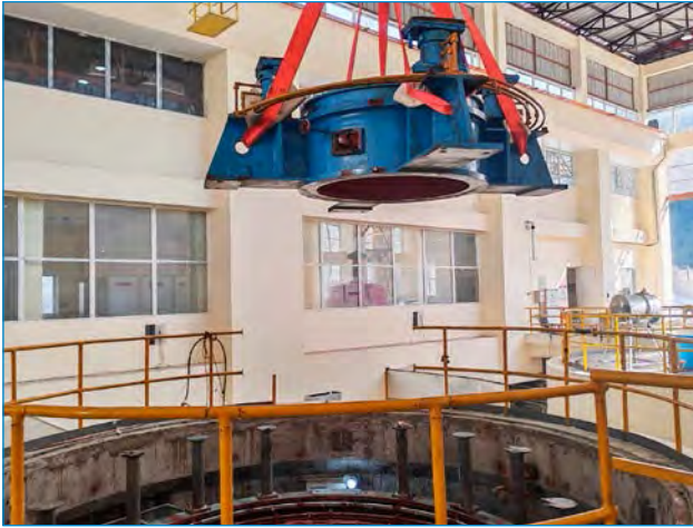
Turbine Unit खोलिएको कार्य
