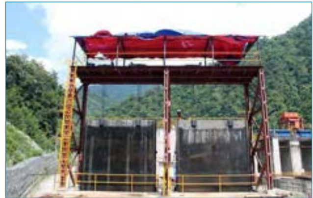
Conveyance Tank मा जडान गरिएका अतिरिक्त गेटहरु
