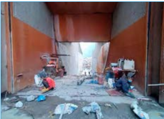
रेडिएल गेटको Sill Beam को मर्मत कार्य
